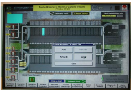
SCADA System der BBA
