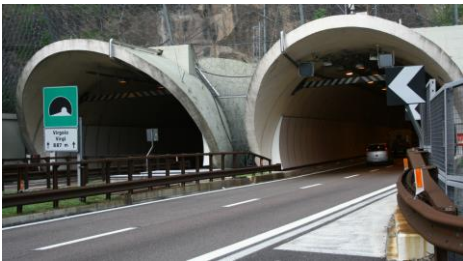
Virgolo Tunnel, Italien
